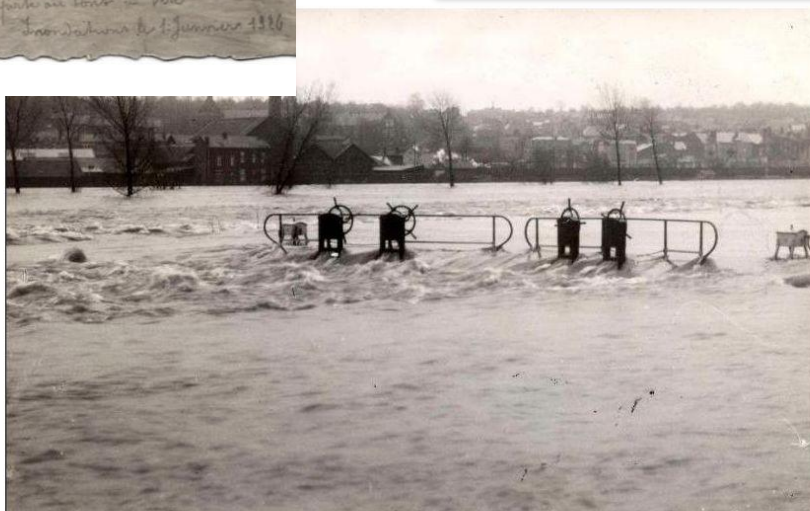
Visé, Basse-Meuse. Ecluse aval en 1926.
